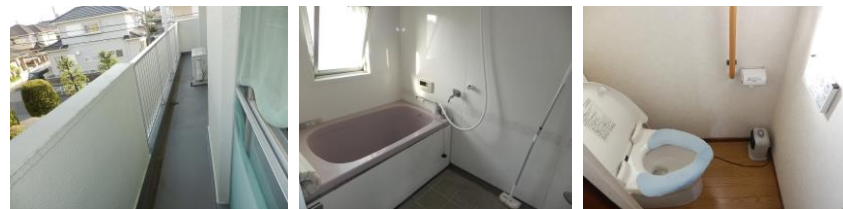
図面と現況が異なる場合は現況を優先とさせていただきます
